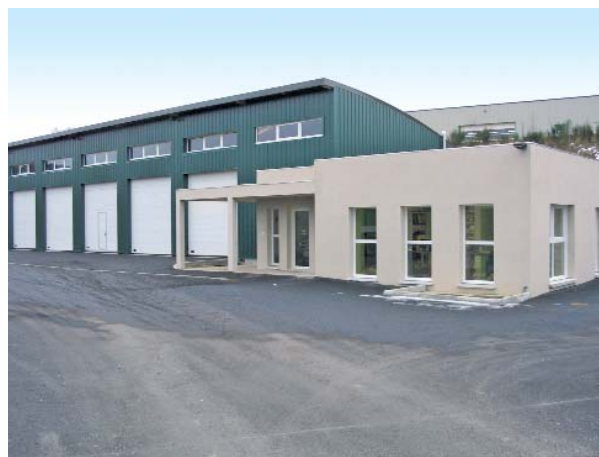
Bâtiment du SICTOM à la ZA Leygat II
