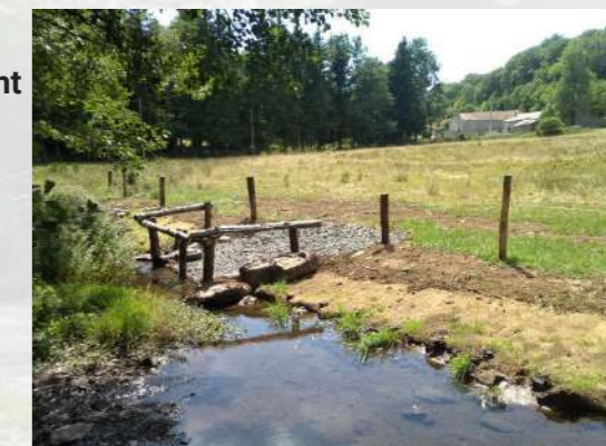
Aménagements de maîtrise du piétinement et de restauration de berges en génie végétal Secteur du Pont de Reynier & Recharinges, Commune d'Araules
