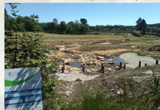
Restauration de la zone humide du « Suchas » Commune de Chenereilles
