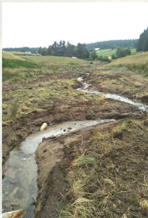
reméandrage sur la Frachette en aval (après)
