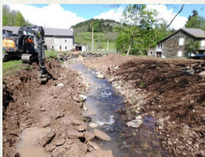
Reprofilage des berges pour réouvrir la section hydraulique
