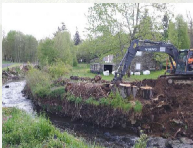
Reprofilage des berges pour réouvrir la section hydraulique
