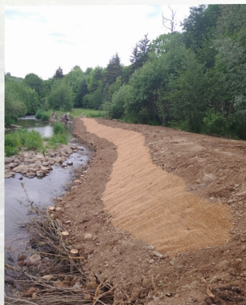
Restauration des berges - fascines de saules (Mathias - Fay-sur-Lignon)
