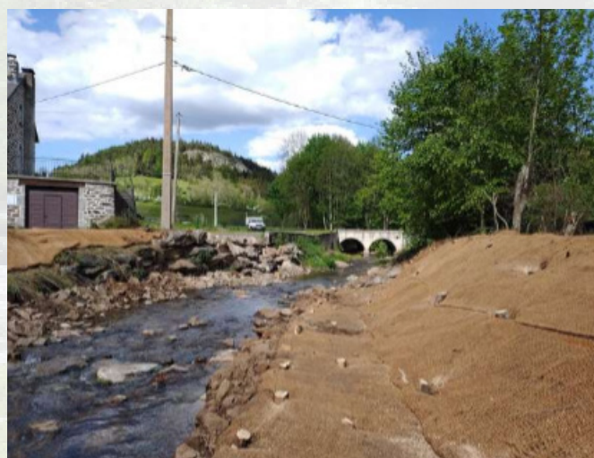
Restauration de berges à l'aide de techniques en génie végétal
