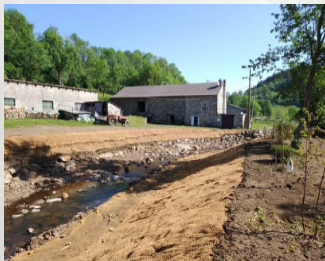
Reprofilage des berges pour réouvrir la section hydraulique
